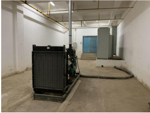
备用发电机（消声、隔声及减振）
